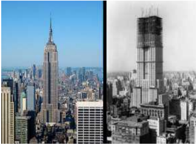
Foto: Empire State Building. En construcción
