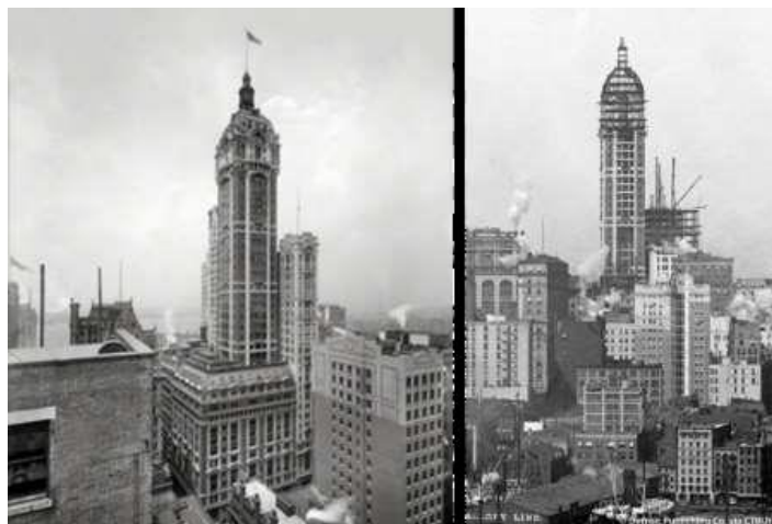
Foto: Singer Building. Construcción.
