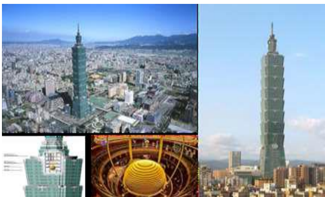
Foto: El Taipei 1011 y el amortiguador de masa ( damper ): un espectáculo dentro del edificio.
