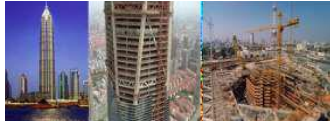
Foto: Jin Mao Tower . En construcción
