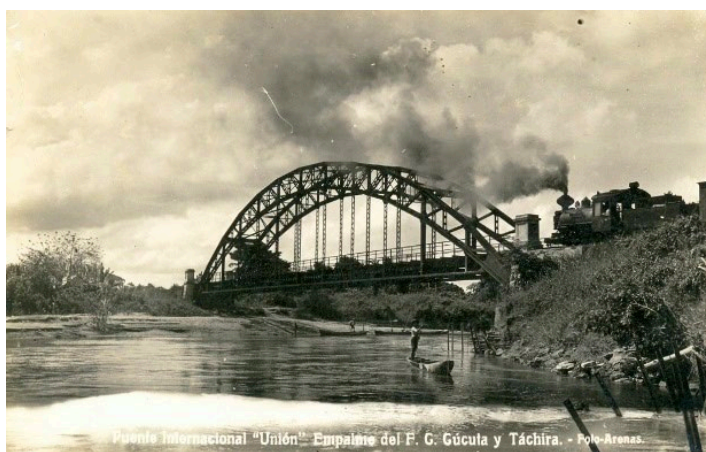
Figura 27. Puente Internacional Unión sobre el río Grita.
