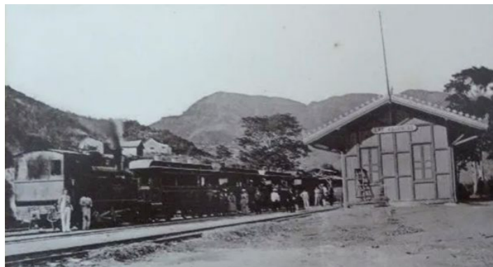
Figura 15. GFV. Estación Las Adjuntas.
