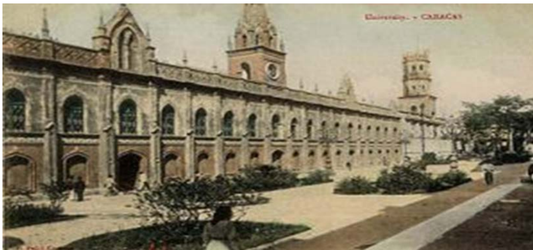
Figura N°4: Convento de San Francisco, Sede de la Universidad Central de Venezuela. Por más de 168 años (1786-1954-) Seguido por el Edif. Biblioteca Nacional (1910-), ubicada entre el Edif. de la Universidad (Convento de San Francisco) y el Palacio de las Exposiciones (1910). Edificio del Ing. Alejandro Chataing
