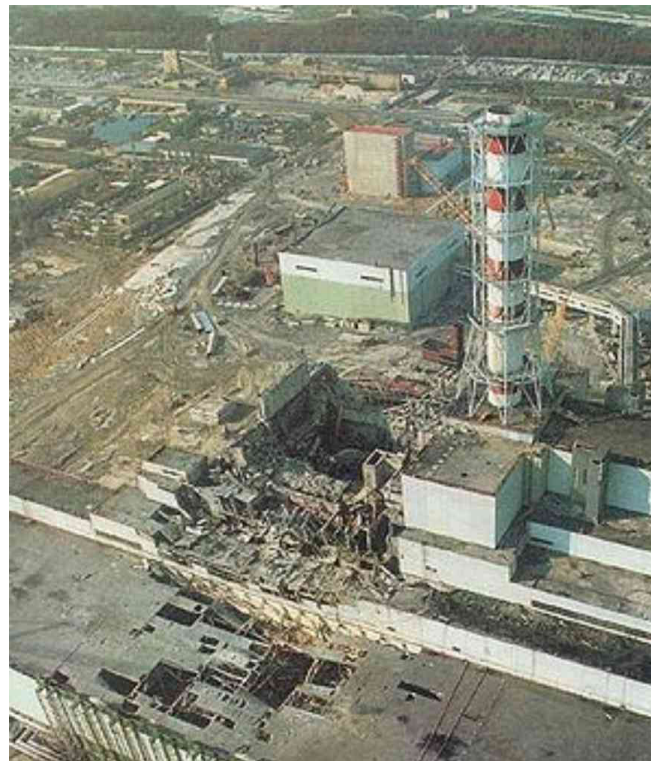
Figura 3. Fotografía aérea del reactor después de la explosión del núcleo.
