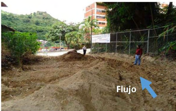
Figura 7. Izquierda: vista desde aguas arriba del tramo del cauce completamente sedimentado antes de la alcantarilla, la cual estaba totalmente enterrada por los sedimentos. Derecha: vista desde aguas abajo del cruce del cauce tributario con la Calle Los Arcos.
