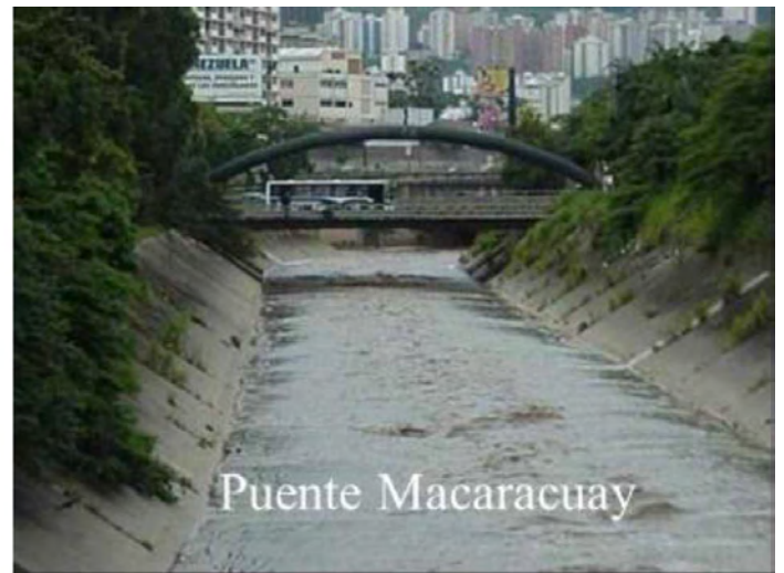
Figura 20. Contracciones verticales del cauce del río Guaire debido a la baja cota de las vigas de los puentes California Sur y Macaracuay.
