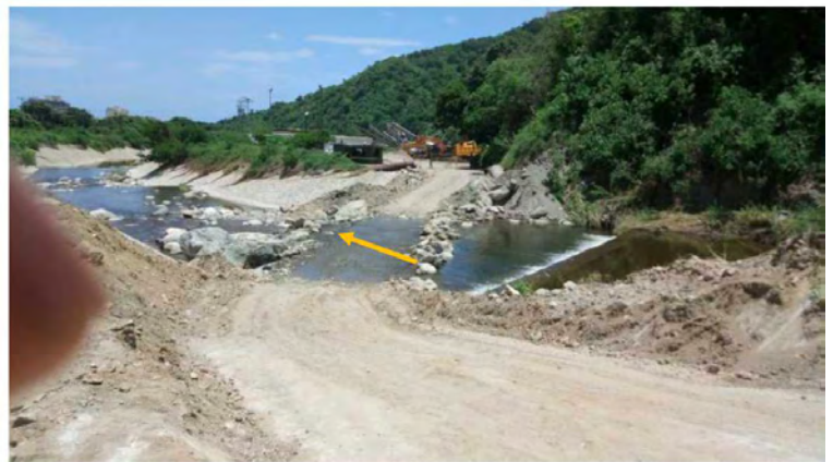
Figura 23. Cruce de carretera sobre canalización del río Camurí Grande, aguas arriba de la población. Vista del terraplén y batería de alcantarillas construido por la empresa arenera para el paso de camiones. Izquierda: foto tomada el año 2011 mostrando el terraplén recién construido (Foto de J.I. Sanabria); Derecha: foto tomada por el autor el 12/09/21, mostrando la destrucción del terraplén por los flujos de 28/08/21.
