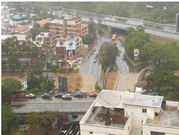
Figura 21. Inicio de la inundación del río Guaire en la California Sur en febrero 2005, causado por la contracción vertical que ejerce el puente. Observe la gran turbulencia del flujo al chocar con las vigas del tablero del puente (Fotos extraídas de Internet).
