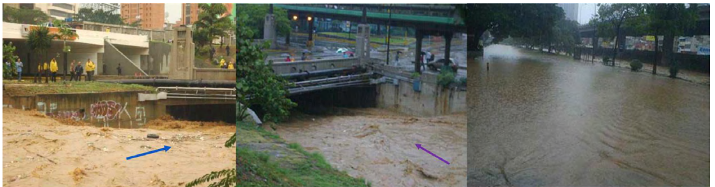
Figura 19. Efectos de la creciente del río Guaire en febrero del 2005. a) Vista de la depresión del flujo en el puente y aumento de los niveles (remanso) hacia aguas arriba (fotos izquierda y centro). b) Inundación en Bello Monte, frente a la Alcaldía de Baruta, en febrero del 2005, debido a los efectos de remanso originados por el puente Las Mercedes (Fotos extraídas de Internet).
