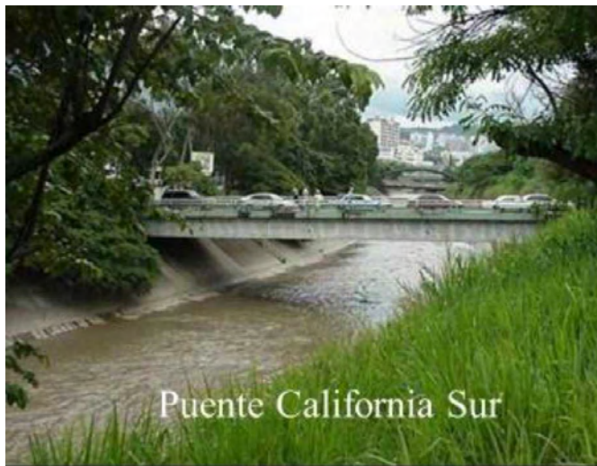
Figura 20. Contracciones verticales del cauce del río Guaire debido a la baja cota de las vigas de los puentes California Sur y Macaracuay.
