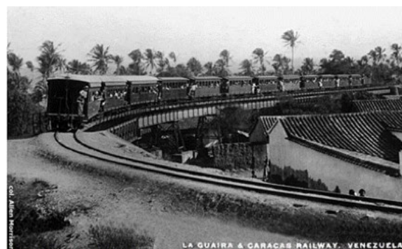
Figura 6. Viaducto de Pariata.
