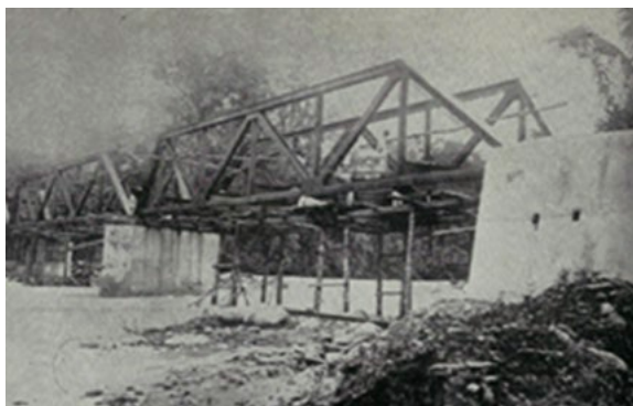
Figura 24: GFT. Puente Lobatera No. 2
