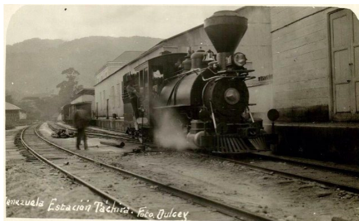
Figura 25. GFT. Estación Táchira.
