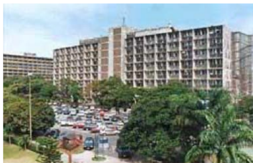
Fachadas del Edificio Facultad de Farmacia, UCV
